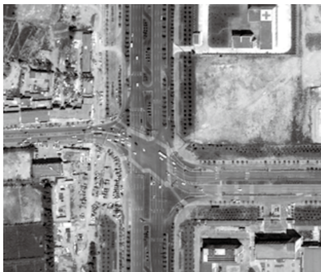
图4 交叉口改造后现场情况
